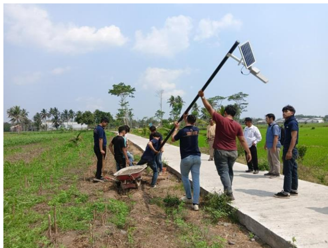
Gambar 1. Pemasangan Tiang Lampu Dilakukan Oleh Tim Pengabdian Universitas Negeri Malang
