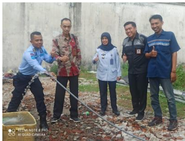
Gambar 1. Air bersih yang dihasilkan dari pengeboran menggunakan Hydraulic Boring
