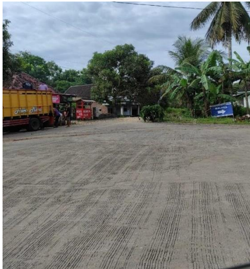
Gambar 1. Tempat Pemasangan Traffic Light dan Kaca Cembung.
