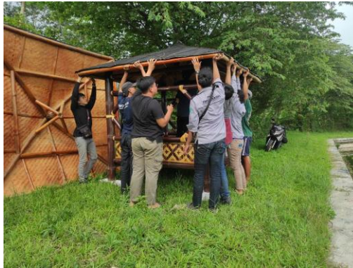
Gambar 6. Pemasangan dan Penyerahan Gazebo di Wisata Embung Desa Banjarejo
