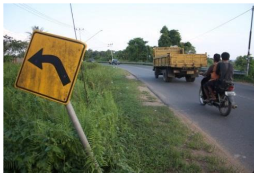
Gambar 3. Salah satu penampakan rambu lalu lintas yang sudah rusak
