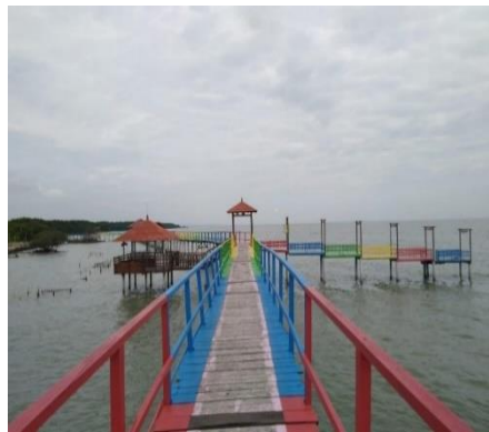
Gambar 4. Jembatan Pantai Kutang
