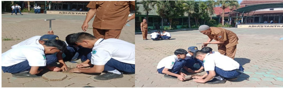
Gambar 1. Pemasangan Biopori (Konservasi Air)
